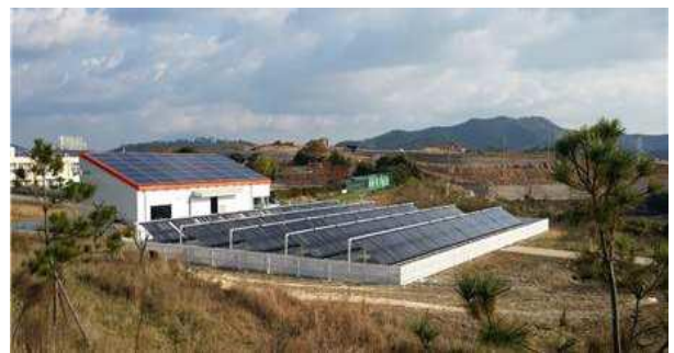
[해수담수화 실증플랜트 전경]
